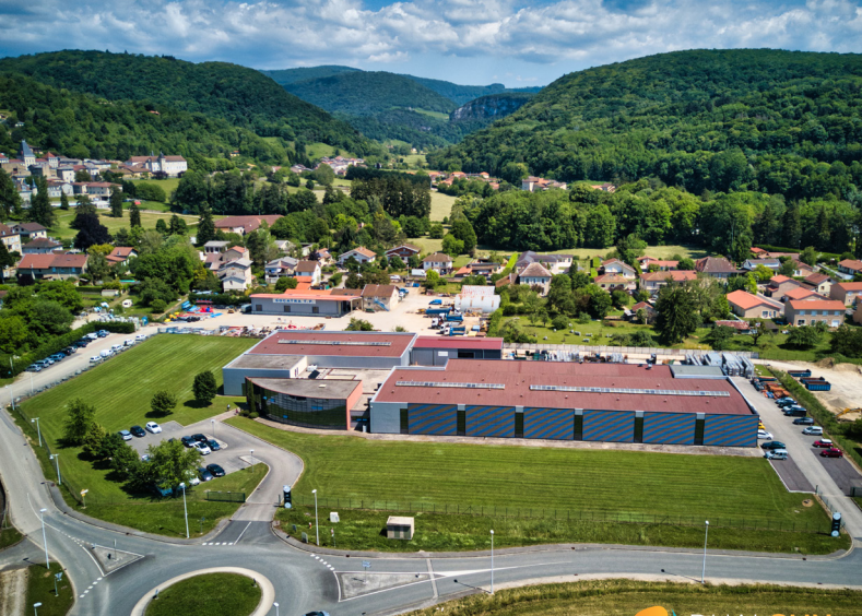
Usine de panneaux solaires hybrides DualSun à Jujurieux, dans l'Ain.
