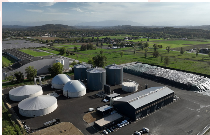
Unité de production de biogaz BioBéarn à Mourenx, en Nouvelle-Aquitaine.
